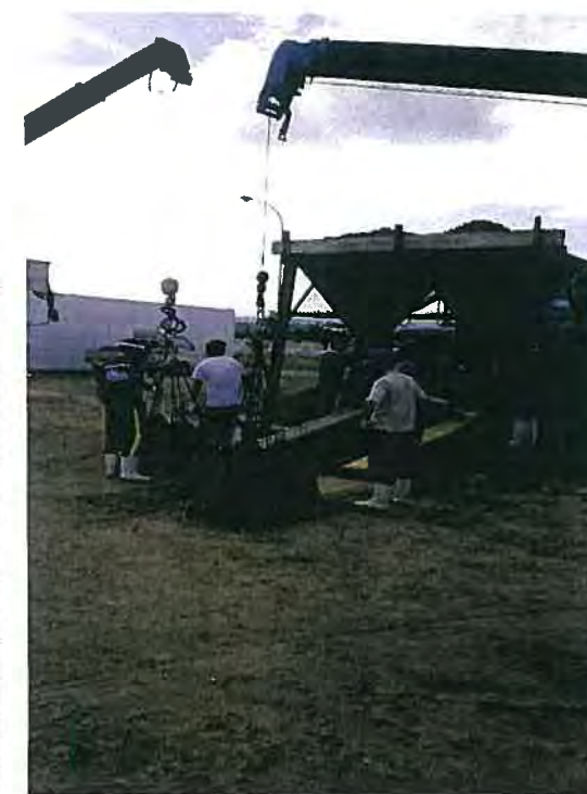
3経営体による土俵詰め作業風景
