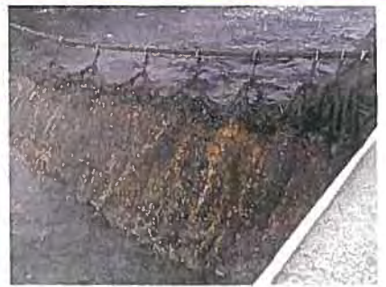
網の汚れが多い場合は巻き上げ作業に時間がかかる。
